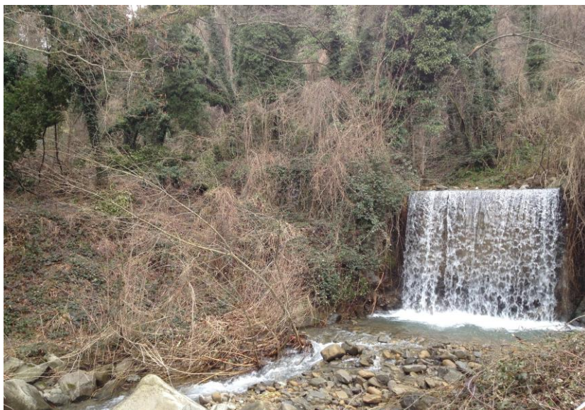
Figura 13: Briglia sul torrente Vincio a monte del ponticello carrabile, dove si prevede di posizionare l'opera di presa della centralina idroelettrica.
