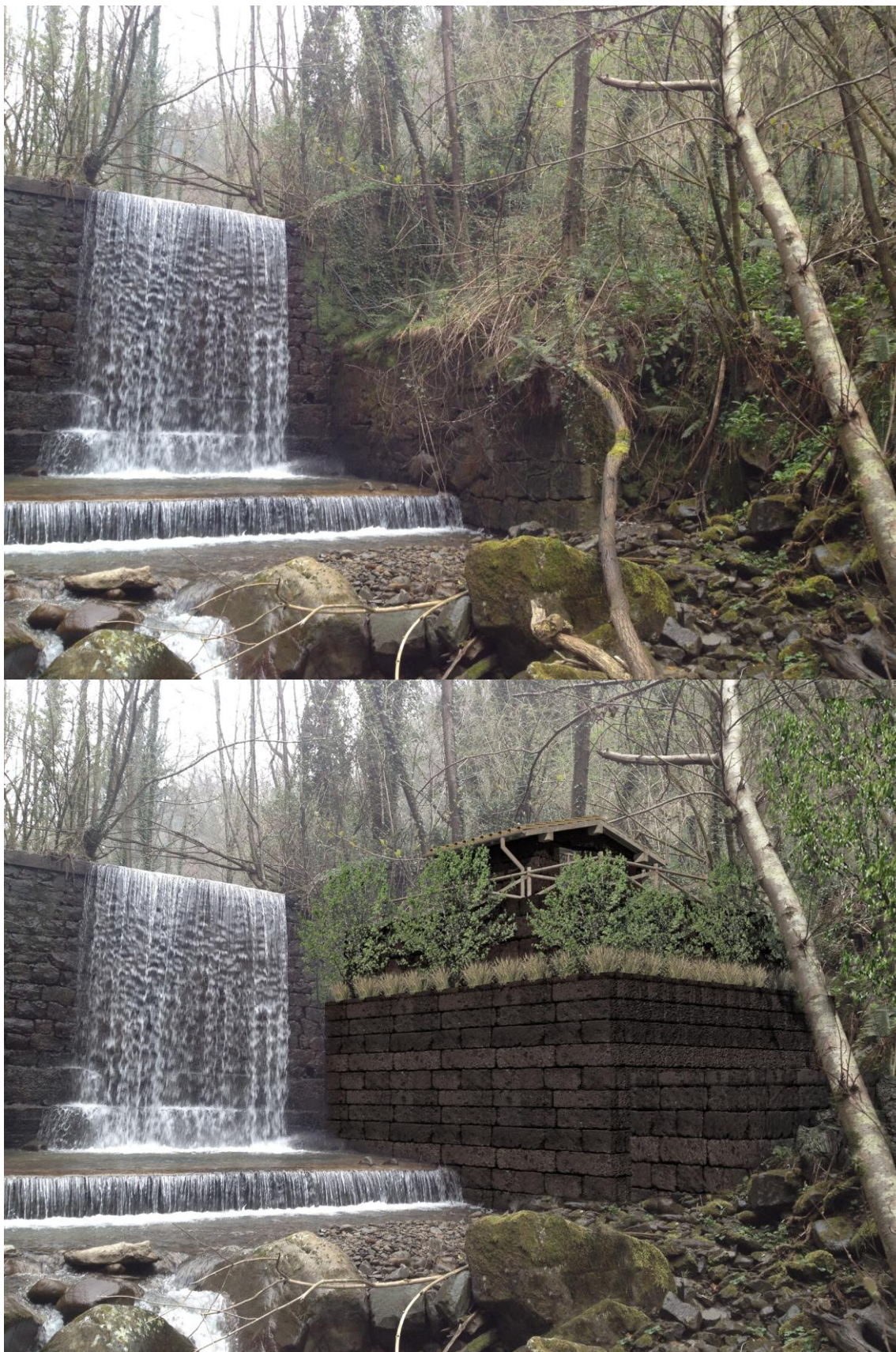
Figura 6-2: Stato attuale e stato di progetto con fotoinserimento della centralina in progetto. Si è cercato di sfruttare il più possibile volumetrie esistenti.
