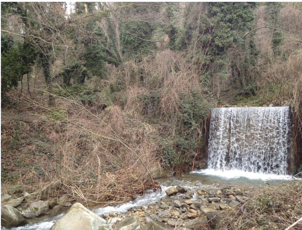
Figura 4-2: PdO F1 - Vista da valle della briglia esistente dove verrà collocata l'opera di presa.
